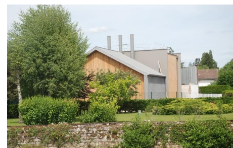
Chaufferie bois à Marnay
