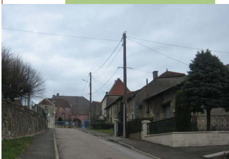
Rue de l'Eglise à Polaincourt-et- Clairefontaine avant travaux
