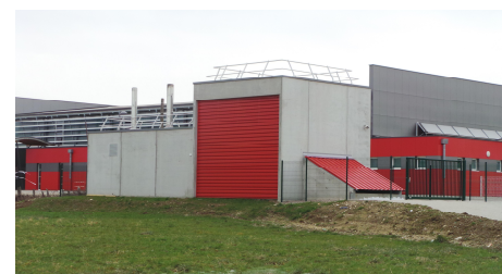
Chaufferie bois à Gy
