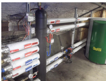
Calorifugeage d'une chaufferie bois
