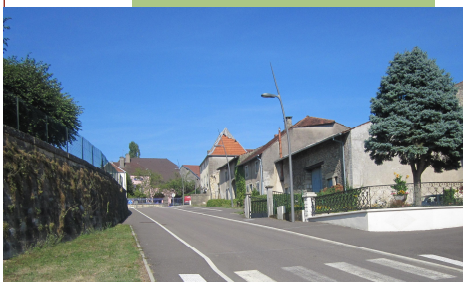
Rue de l'Eglise à Polaincourt-et- Clairefontaine après travaux
