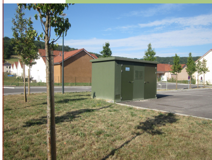
Poste de transformation
