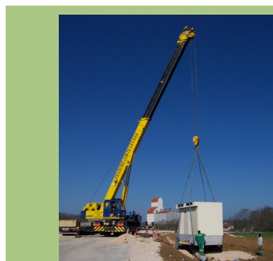
Positionnement d'un transformateur à Noidans-le-Ferroux
