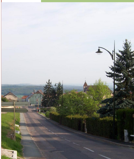
Rue J. et C. Perchot à Saint-Remy après travaux
