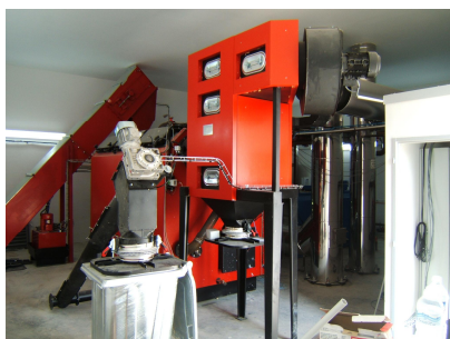
Chaudière bois à Scey-sur-Saône
