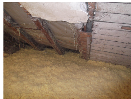
Isolation de combles perdus par flochage
