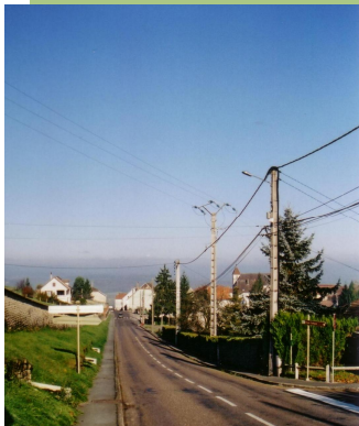
Rue J. et C. Perchot à Saint-Remy avant travaux
