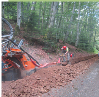
Travaux d'extension de réseau
